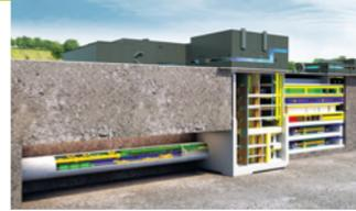
↑ Hamburg-Bahrenfeld ist der Startpunkt des supraleitenden Linearbeschleunigers. Er bringt Elektronenpakete bei einer Temperatur von -271 °C auf einer Strecke von 1,7 km auf eine Energie von 17,5 Milliarden Elektronenvolt.
