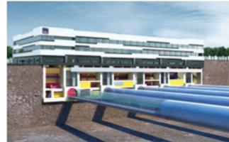
↑ In Schenefeld münden fünf Photonentunnel in die unterirdische Experimentierhalle, in der Spitzenforscher aus aller Welt arbeiten werden. In dem darüberliegenden Gebäude befinden sich die Labors und Büros.
